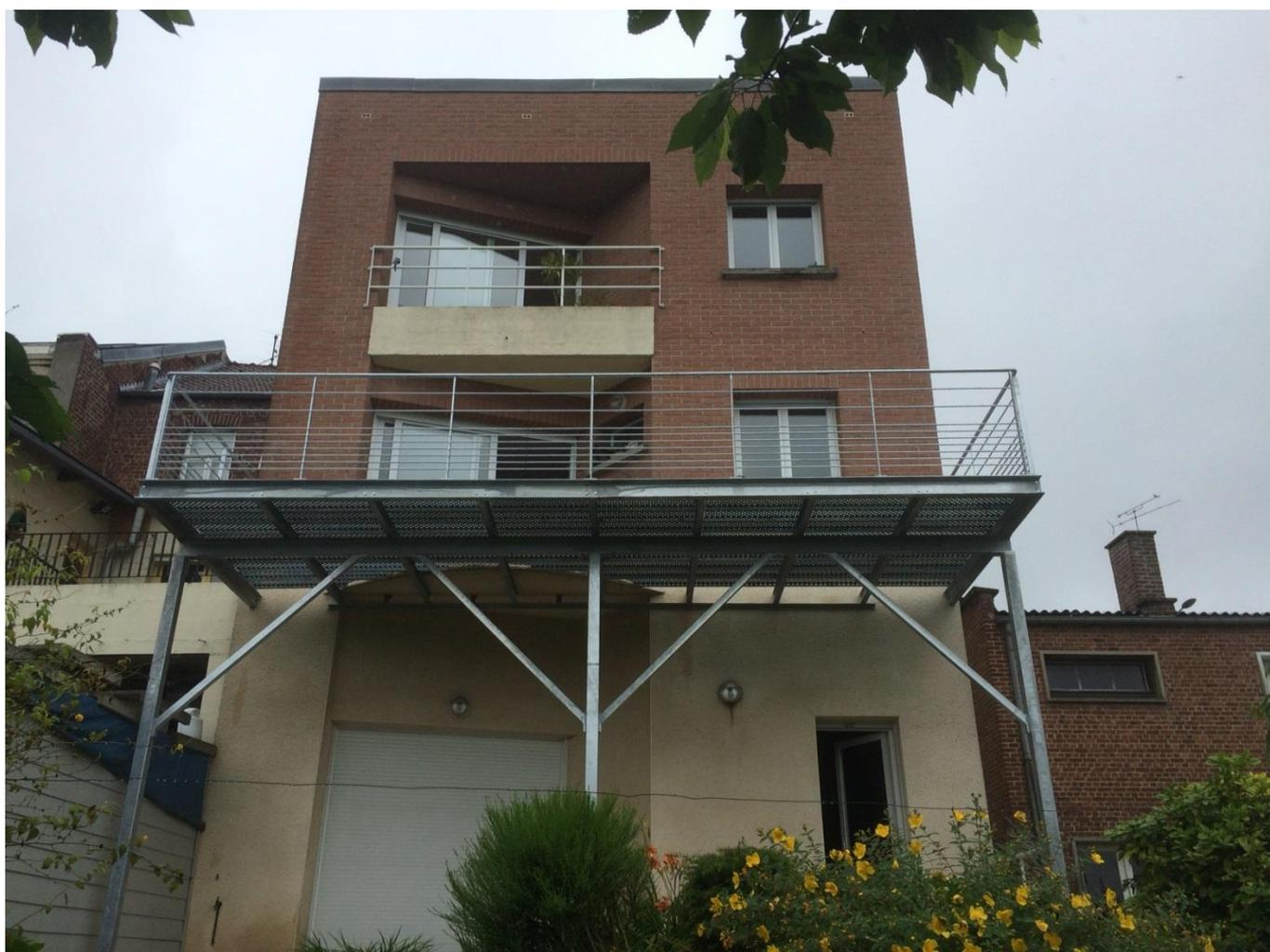
Pour réaliser le plancher de cette terrasse, le client a choisi la perforation TOLMIXTE (trous 5/8 emboutis vers le haut antidérapant et trous 16/23 emboutis vers le bas drainant). Avec un échantillon, le client s'est assuré que le TOLMIXTE ne blesserait pas les pattes de son chat.
