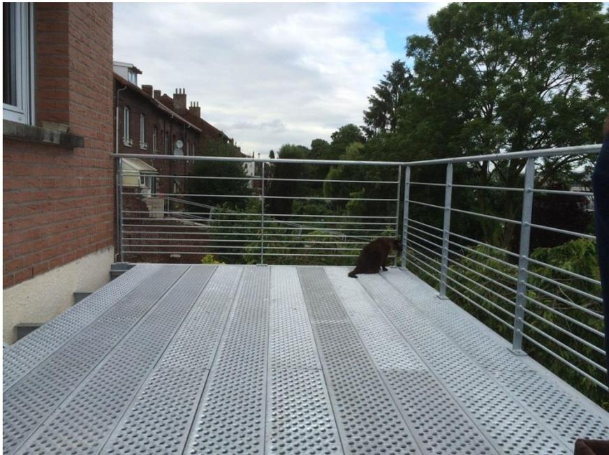
MEISER a proposé des profils en acier galvanisé à chaud selon ISO 1461, d'épaisseur 2 mm. La terrasse est composée de 11 profils de 4 356 mm de longueur, de 240 mm de largeur et de 11 autres profils de 2 602 mm de longueur et 240 mm de largeur, pour une hauteur de 50 mm.
